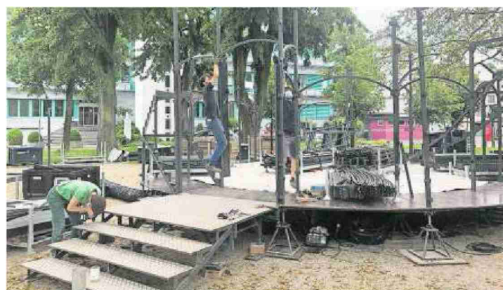
Am Sonntag begann der drei Tage dauernde Aufbau des Silos.
